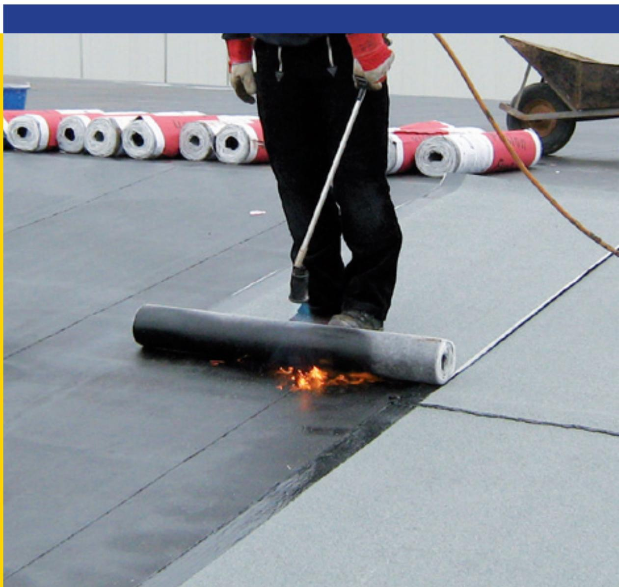
Aufgrund der sich verändernden Klimabedingungen müssen ebenso die eingesetzten Baumaterialien permanent angepasst werden. Temperaturunterschiede auf einem Flachdach von oftmals mehr als 100 K verlangen sowohl im Wärmestandverhalten als auch in der Kälteflexibilität mehr als den in der DIN geforderten Standard. Egal ob Kälte, starke Hitze oder Gebäudebewegungen,
