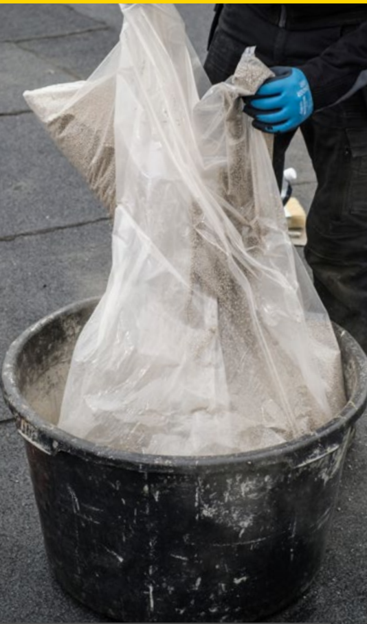
1. HassoForm Schüttung in Rundkübel füllen
