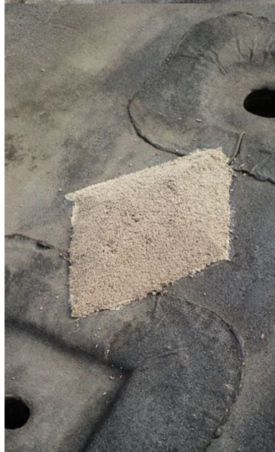
8. HassoForm aushärten lassen (2 bis 3 Stunden)
