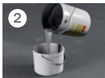
2 BENÖTIGTE MENGE IN SAUBEREN MISCH- EIMER ABFÜLLEN
