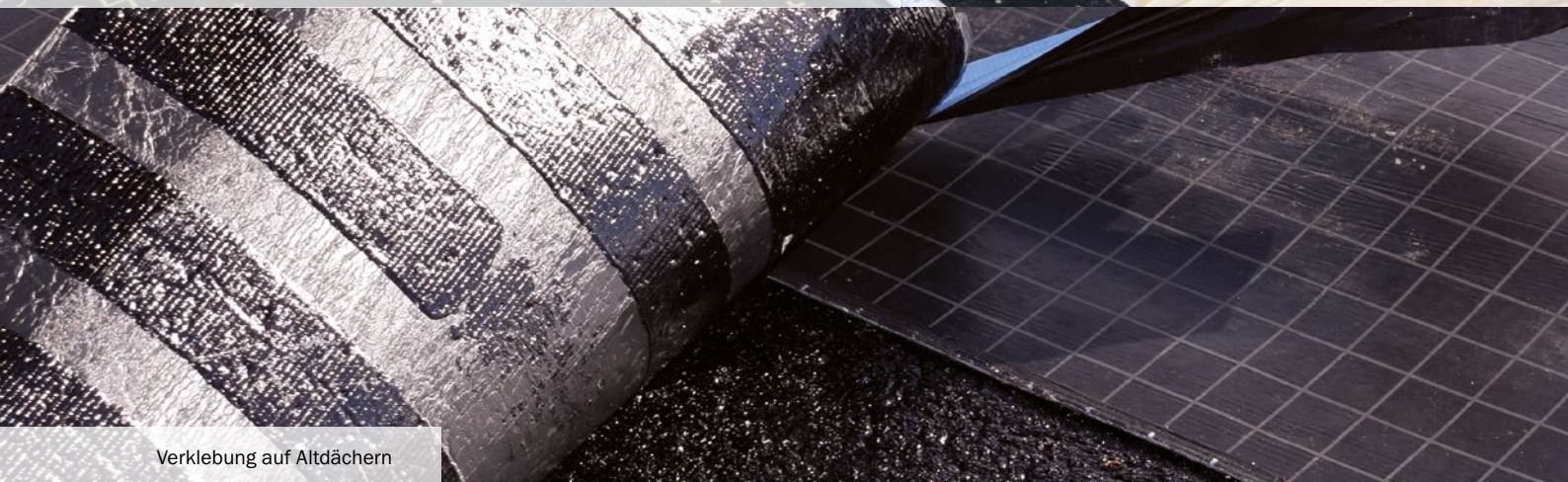
Befestigung auf Holzuntergründen (Flächenfolie verbleibt unter der Dachbahn)
